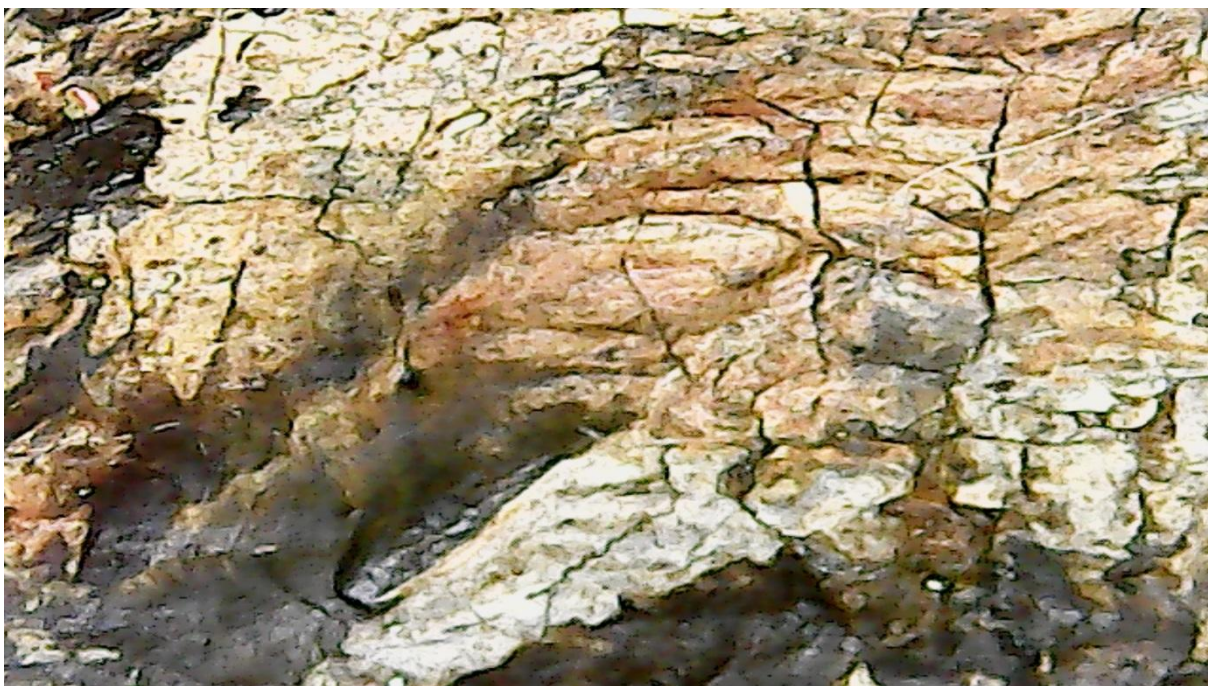
A kendő alatti homlok
