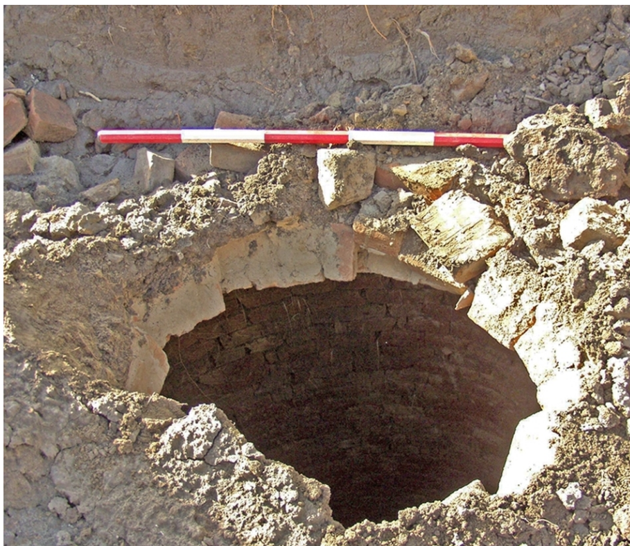
8. kép: A téglaboltozat a felnyitás után
