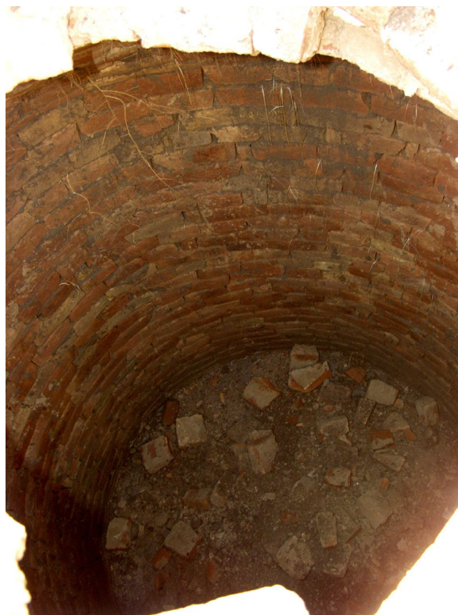
9. kép: A kút oldalfalai és alja (alján a felnyitáskor behullott téglákkal)
